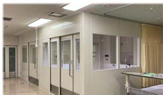
写真52 感染対策工事を行った血液透析室
