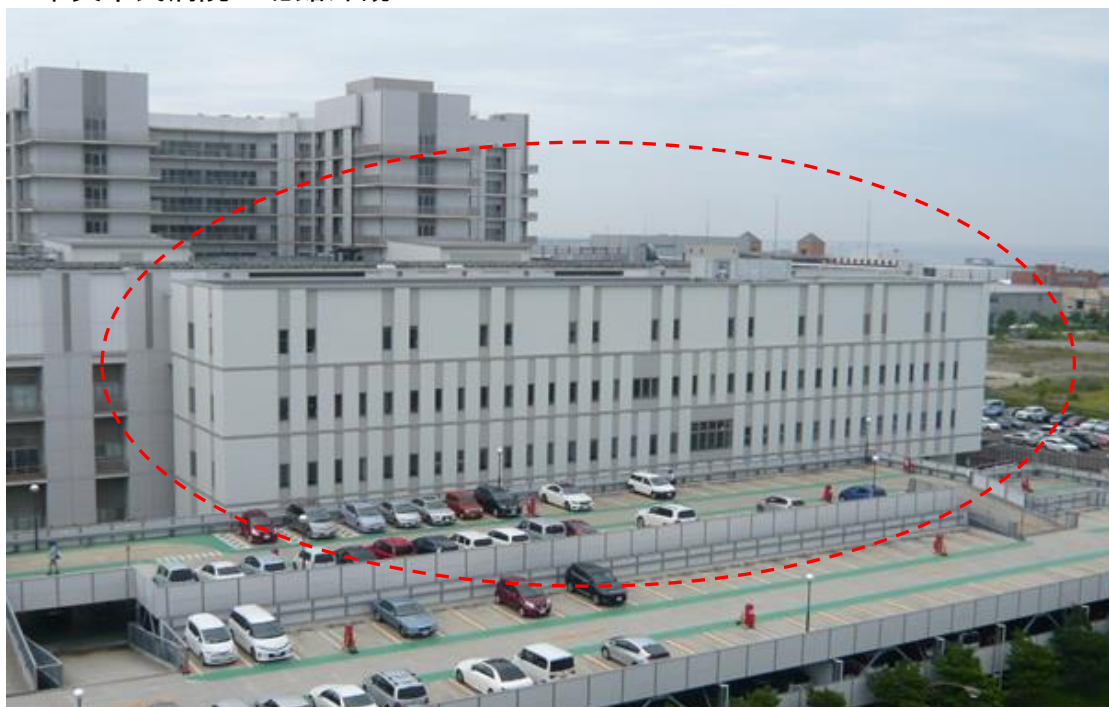
・ 中央市民病院 北館外観
